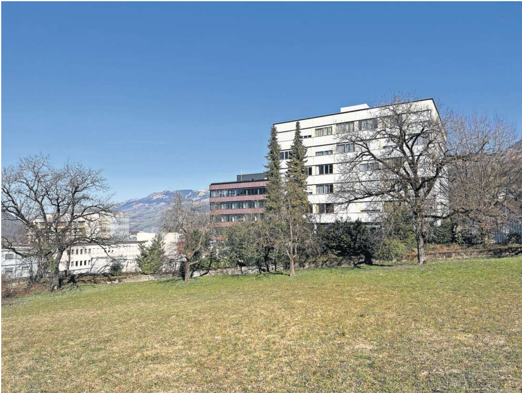
Das Personalhaus des Spitals Schwyz hätte abgerissen werden sollen.
