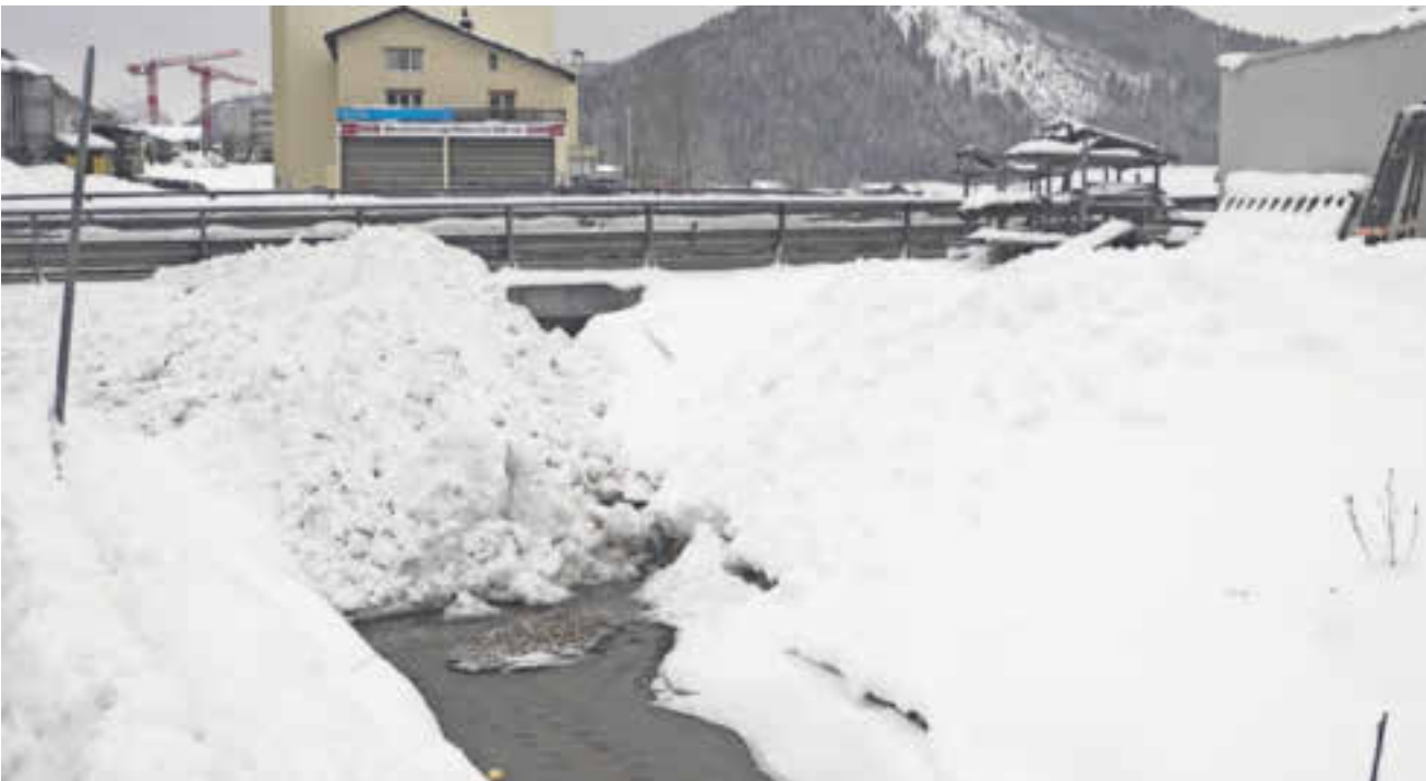
Eine private Schneeablagerung vor einer Brücke, welche zu einer Verstopfung des Gerinnes geführt hat. Bild: Amt für Gewässer
