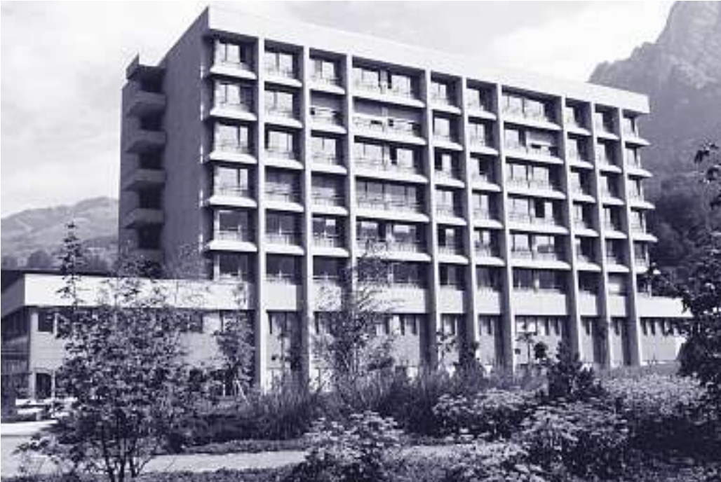
Ansicht der Fassade des im März 1981 neu bezogenen Spitals Schwyz.
