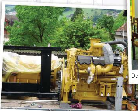
Zur Sicherheit: Das neue Notstromaggregat
