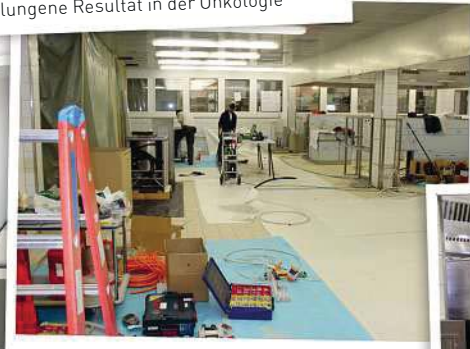
Hier entsteht die neue Küche.
