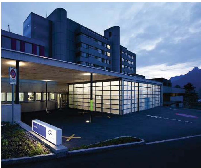
Garage für die Ambulanz, wo Patienten wetter- und sichtgeschützt aus dem Rettungsfahrzeug übernommen werden
