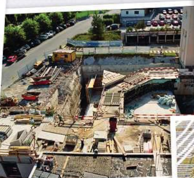
Das Haus C im Rohbau
