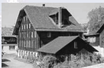
Das Bauernhaus im Tschaibrunden
